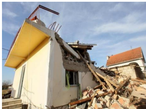
Srušena kuća u Žiči kod Kraljeva, 3.11.2010.
