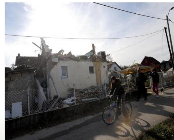
Oštećena kuća u Vitanovcu kod Kraljeva, 3.11.2010.
